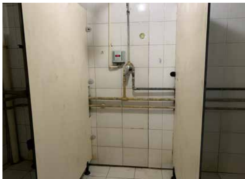
北外一號樓整修過後的浴室
