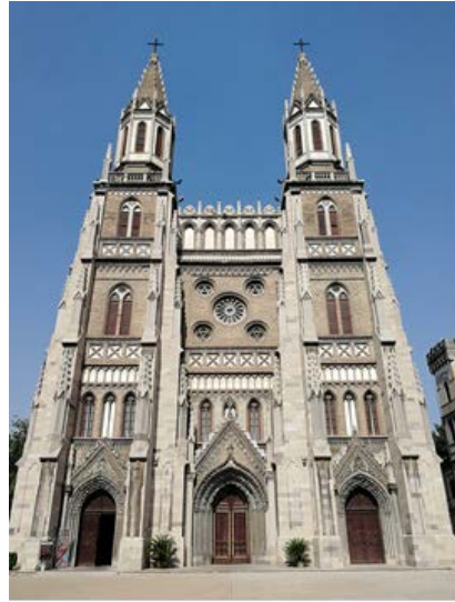
照片說明：山東濟南洪家樓教堂
